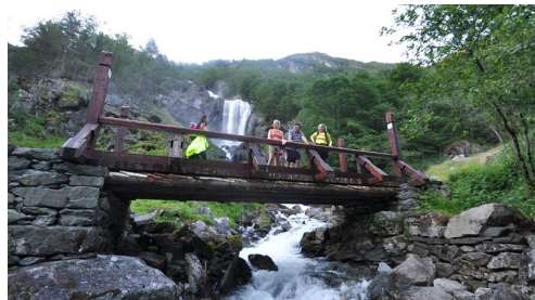
Kongevegbrua over elva og fossen Sokni.
